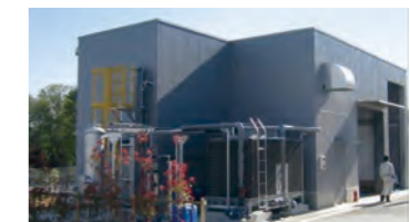
東京工場水処理設備
